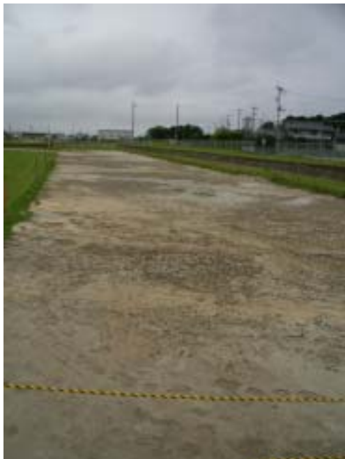
写真 14: 亘理町陸上競技場の液状化 1
