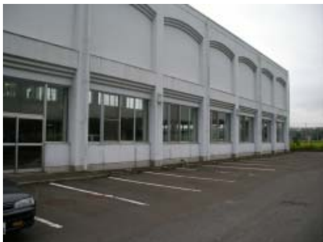
写真 7: 根白石温水プール外観
