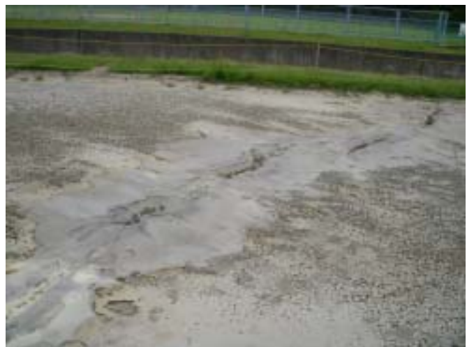
写真 15: 亘理町陸上競技場の液状化 2
