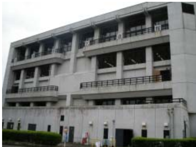
写真 10: 宮城県武道館外観
