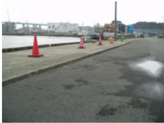
写真 20 荒津での護岸の変形、道路の沈下 (中央区荒津)
