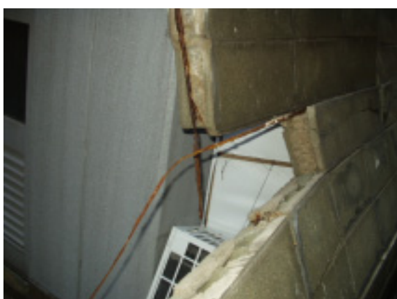
写真 14 ブロック塀の倒壊（中央区大名周辺）
