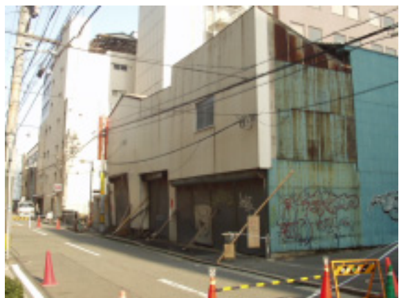
写真9 倒壊の危険性ありとされた木造建物 (中央区舞鶴2丁目)
