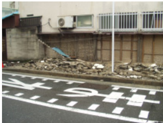
写真 13 ブロック塀の倒壊 （中央区薬院 1 丁目）
