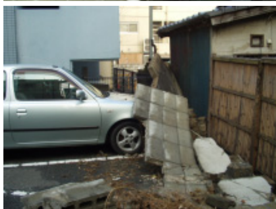
写真 14 ブロック塀の倒壊（中央区大名周辺）
