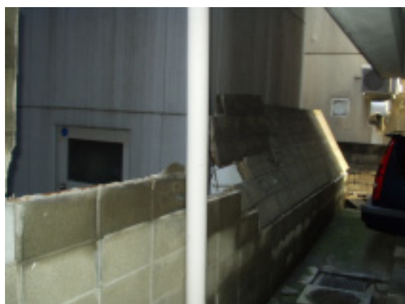
写真 13 ブロック塀の倒壊 （中央区薬院 1 丁目）
