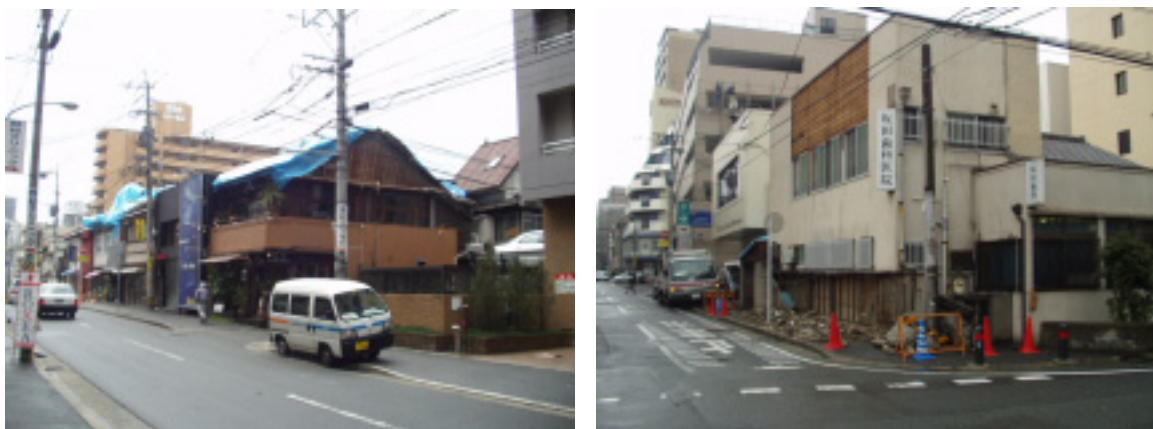
写真7 低層木造住宅の被害（中央区今泉周辺）
