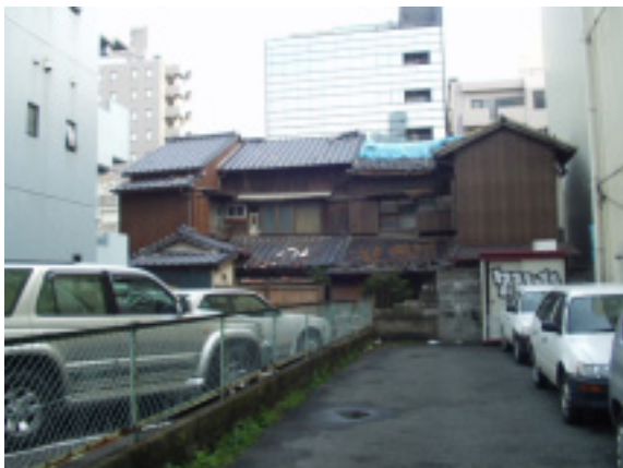
写真8 低層木造住宅の被害 (中央区大名周辺)
