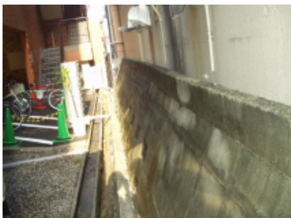
写真 12 安国寺石積み塀の倒壊 （中央区天神 3 丁目）
