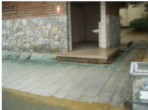
写真 21 海浜公園内のトイレ周辺での沈下 (西区愛宕浜)
