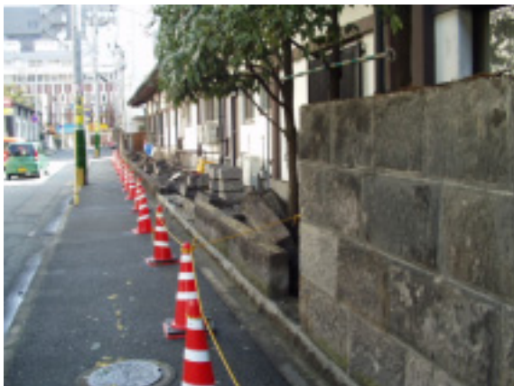
写真 12 安国寺石積み塀の倒壊 （中央区天神 3 丁目）
