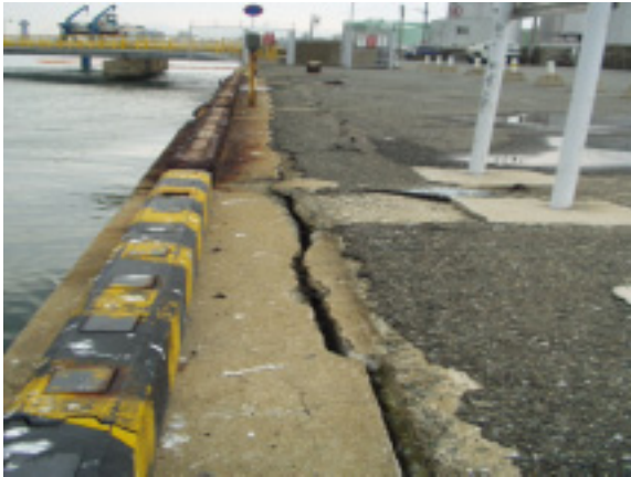
写真 20 荒津での護岸の変形、道路の沈下 (中央区荒津)
