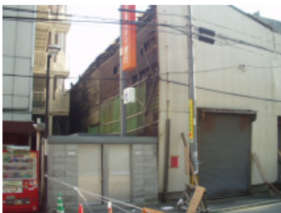
写真9 倒壊の危険性ありとされた木造建物 (中央区舞鶴2丁目)
